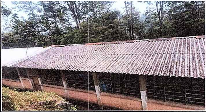
Foto1: Sustitución de techo
