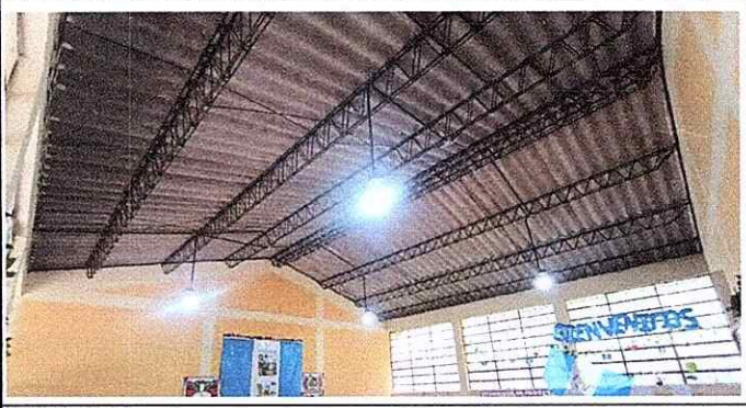
Foto 2: Sustitución de de estructura metálica de techo
